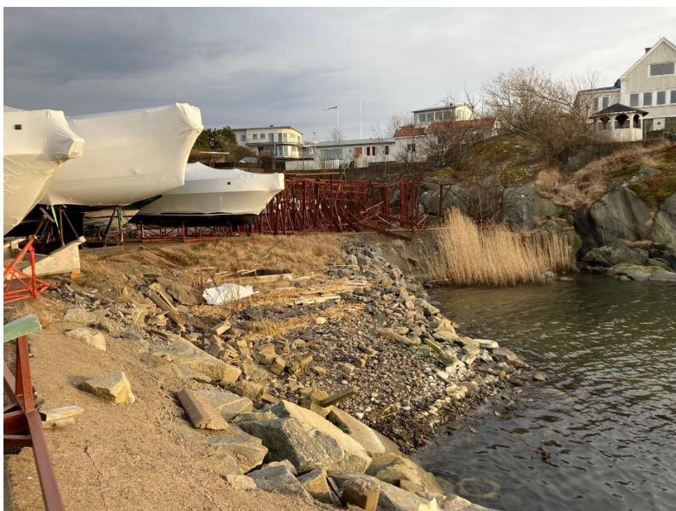
Figur 9 Foto mot söder med befintligt erosionsskydd (COWI 2022-03-25)
